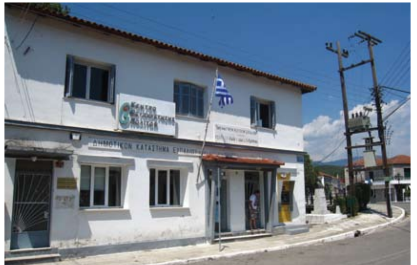
Σημαντικές παρεμβάσεις έγιναν τόσο στη στέγη του κτηρίου που στεγάζει το Πνευματικό Κέντρο, το ΚΕΠ, το Γραφείο Κοινότητας και το ATM όσο και στην αίθουσα του Πνευματικού Κέντρου που βρίσκεται η Βιβλιοθήκη για να ξαναγίνει ο χώρος σωστή και λειτουργική Βιβλιοθήκη.
