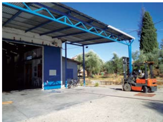
Ο εξωτερικός χώρος του ελαιοτριβείου Αντωνόπουλου
