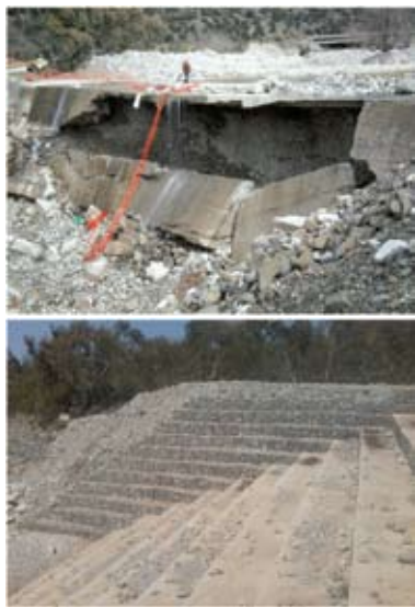
Η διέλευση στο Καρουτιανόρεμα, στην είσοδο του Μαραθιά, πριν και μετά τα έργα
