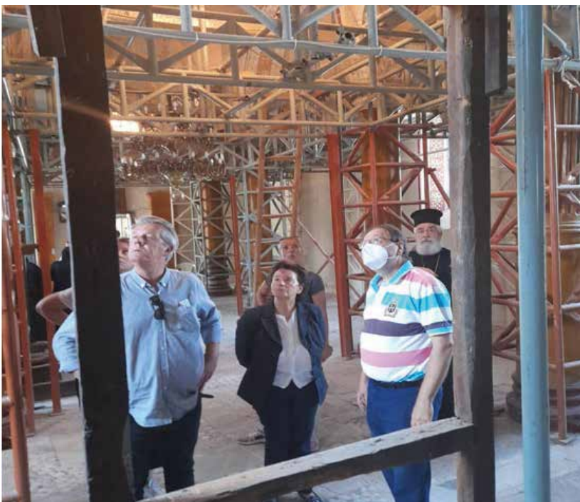
Ο Μητροπολίτης Φωκίδας κ.κ. Θεόκτιστος, ο Προϊστάμενος της Διεύθυνσης Αναστήλωσης Βυζαντινών και Μεταβυζαντινών Μνημείων κος Θεμιστοκλής Βλαχούλης, η Ομότιμη Καθηγ. ΕΜΠ κα Αντωνία Μοροπούλου, ο κος Χαράλαμπος Μουζάκης Αναπλ. Καθηγητής ΕΜΠ Πολιτικός Μηχανικός
